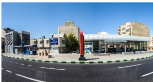
شکل (۸). ناهماهنگی بدنه ایستگاه مترو
