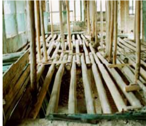
شکل (۷). سقف تیر پوش چوبی در تبریز با رعایت همپوشانی و یکپارچه سازی برای حفظ زلزله منسج: فخا، ۷، تهرانه، ۱۳۸۵
