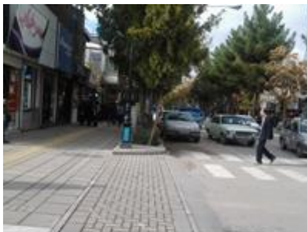
شکل (۶) اختلاف سطح (لبه، پله، سکو و ...) در مسیر عبور در معابر پیاده
