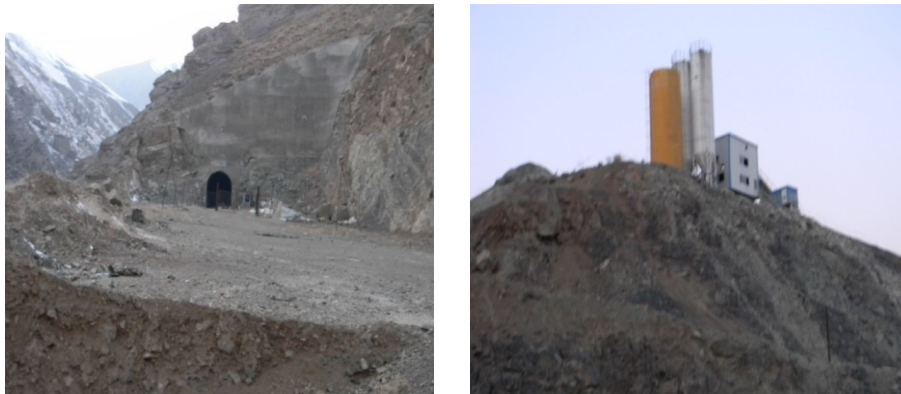
شکل (۱۱). تصاویری از عملیات ساخت تونل در مسیر
