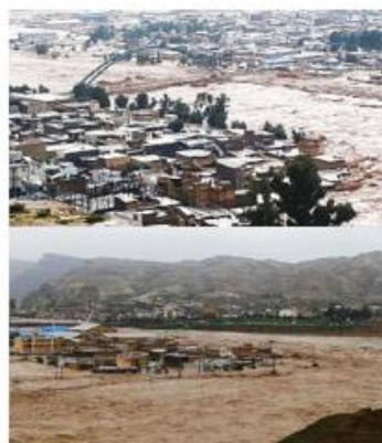
شکل (۵). وضعیت ساختمان ها در حریم رودخانه کشکان در پلدختر هنگام وقوع سیل
