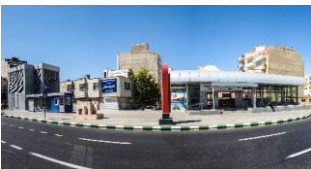
شکل (۸). ناهماهنگی بدنه ایستگاه مترو
